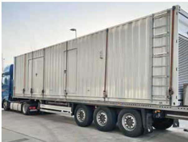
Abbildung 3: Zur Netzersatzanlage umfunktionierter Überseecontainer
